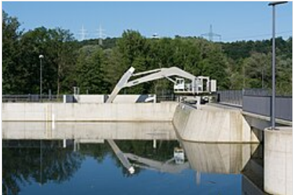
Čiščenje naplavljenih smeti pred vstopom vode v turbino HE Kalsdorf (19 MW), južno od Gradca
